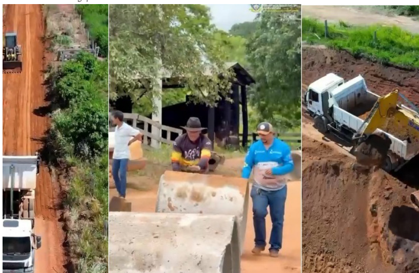
Os trabalhos incluem encascalhamento da estrada principal, instalação de manilhas em pontos críticos
