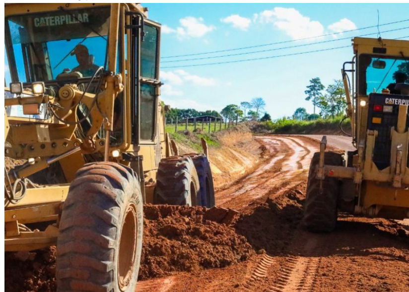
A Seminfram conta com várias equipes em campo para garantir a celeridade e qualidade na execução dos serviços
