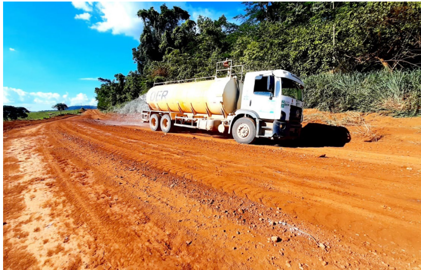
DER executa obras de melhoria na Rodovia 010 que liga o município de Mirante da Serra ao distrito de Tarilândia
