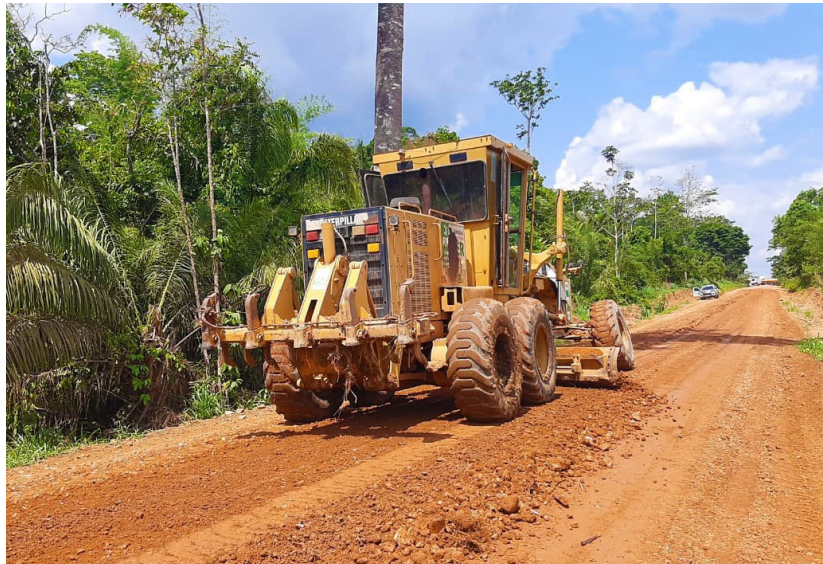
Equipes realizam encascalhamento da RO-010
