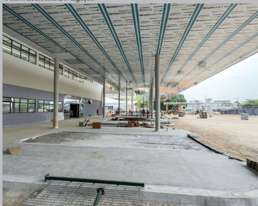
Com 8.457 metros quadrados de área construída, o novo terminal terá 13 plataformas de embarque e desembarque
