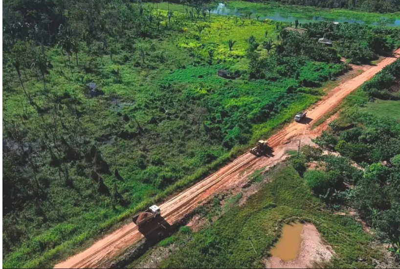
O trecho da RO-010 em recuperação liga Mirante da Serra a Urupá e também ao Distrito de Tarilândia em Jaru
