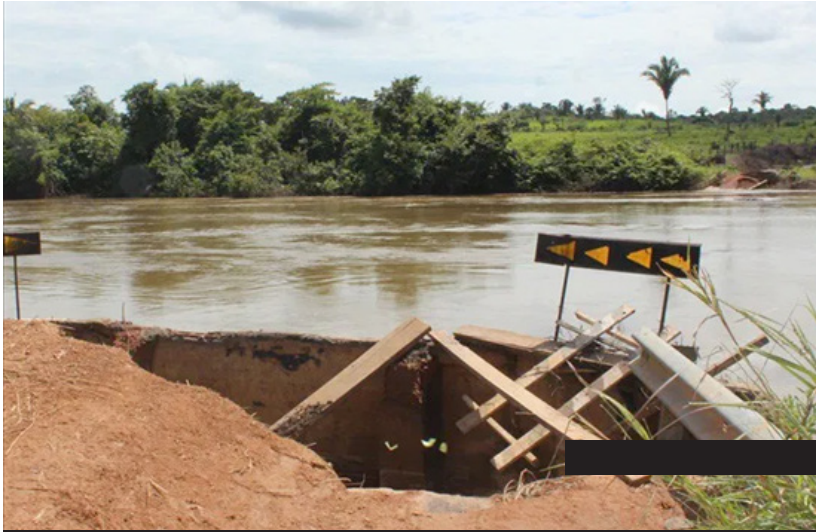
Previsão inicial era que nova ponte, na RO-459, seria entregue em setembro deste ano. Local está sem ponte desde 2019
