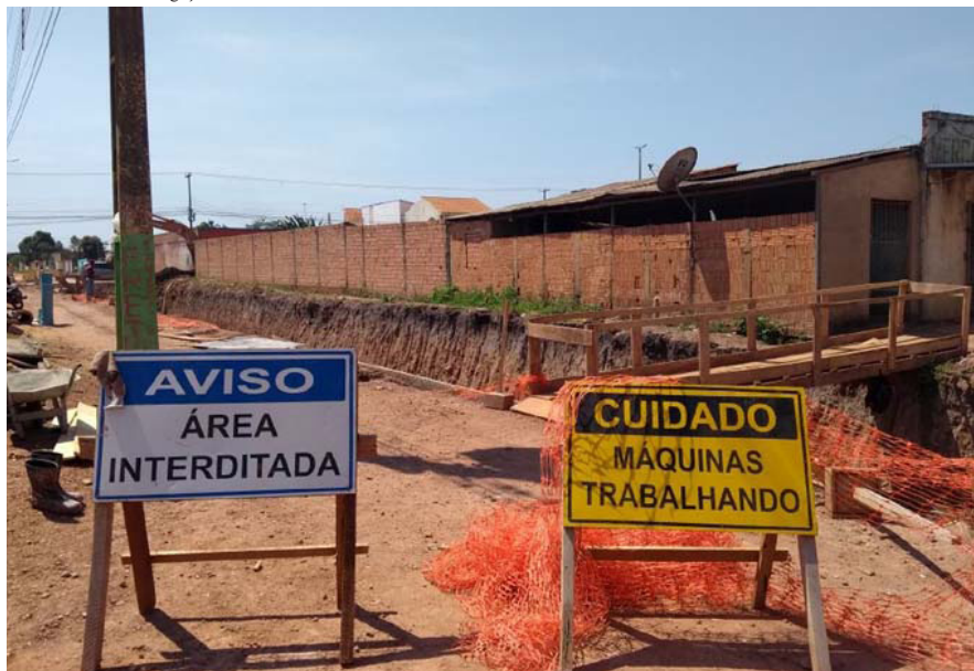
Serão construídas galerias pluviais pela prefeitura de Porto Velho para resolver o problema de alagamento na Mamoré
